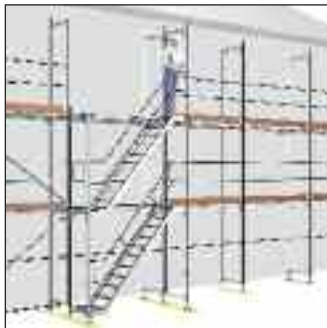
Rys. 54: Montaż poręczy schodów
