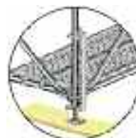
Ryc. 86: Mocowanie śruby przy pomocy zacisku klinowego
